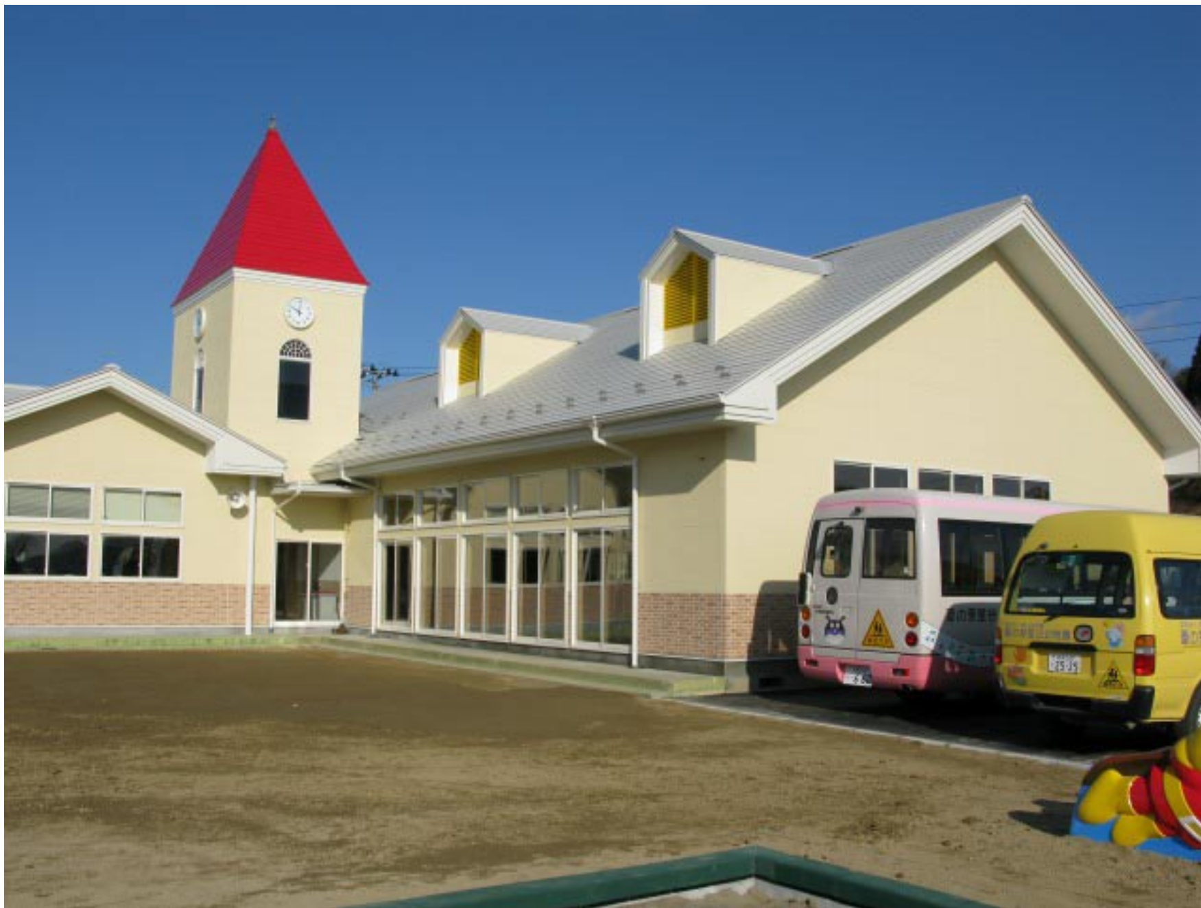
Zespół Szkolno-Przedszkolny Ashinome Hoshiya w Kesenuma, w prefekturze Miyagi. Ze środków przekazanych przez PAH została odbudowana sala gimnastyczna budynku zniszczonego przez kilkunastometrowe fale tsunami. W przedszkolu uczy się około 200 dzieci. Fot. Kei Mori. Źródło: Zbiory PAH
