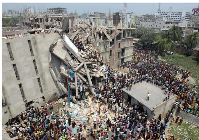
Na zdjęciu budynek Rana Plaza w Savar (Bangladesz) po katastrofie z 24.04.2013 r. Źródło: www.ulicaekologiczna.pl
