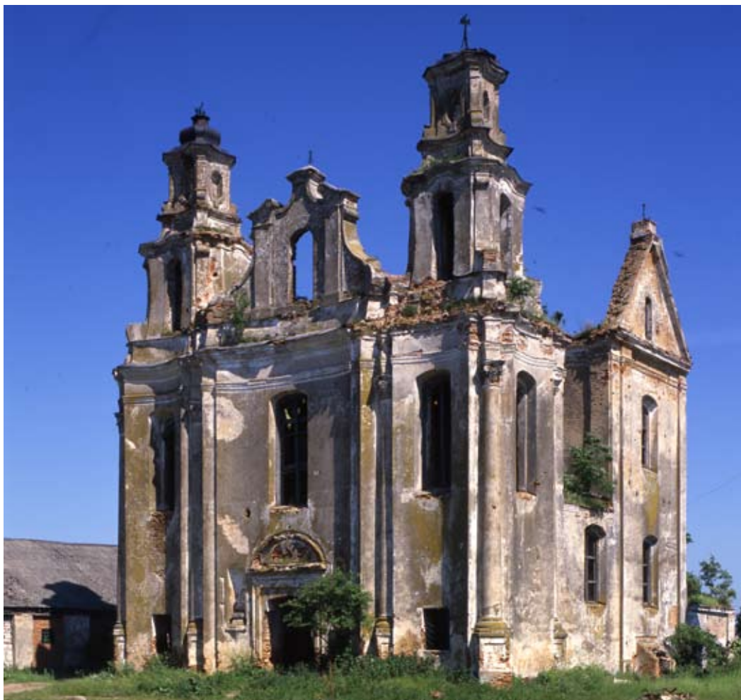
Kościół Dominikanów p.w. Wniebowzięcia NMP
