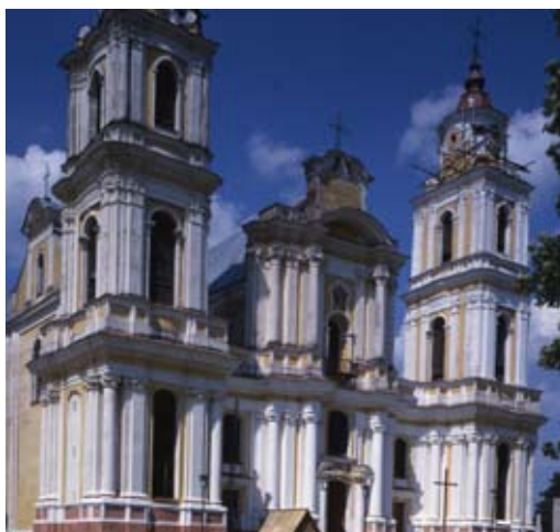
Fasada kościoła Bernardynów p.w. Wniebowzięcia NMP
